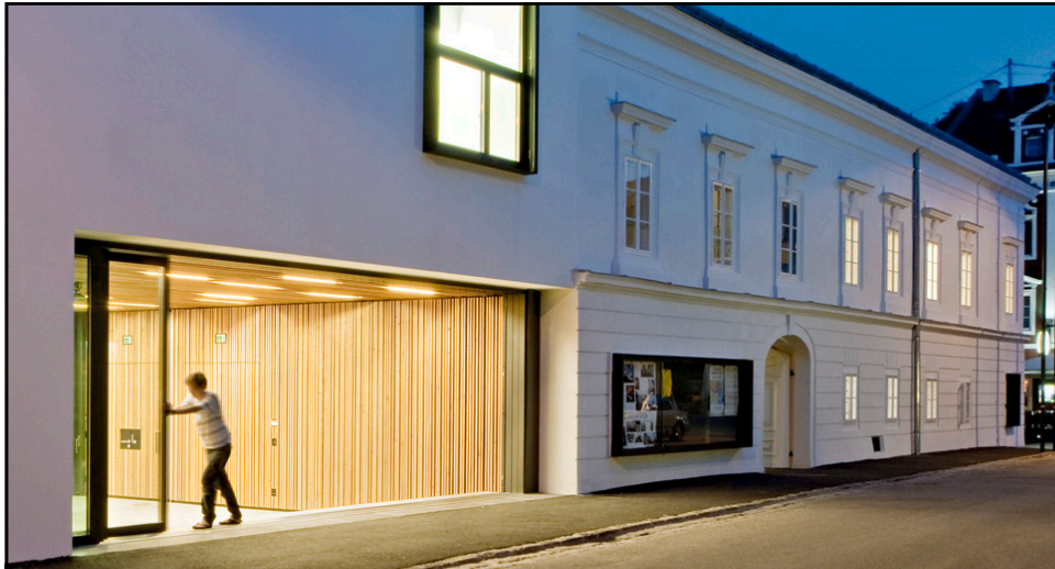
Rathaus Ottensheim (OÖ) – Denkmalschutz Restaurierung und Zubau Projekt: Das offene Amtshaus Ottensheim | Baujahr/Sanierungsjahr: 1500/2010 Architektur: Sue Architekten ZT KG | Bauherr: Verein zur Förderung d. Infrastruktur der Marktgemeinde Ottensheim & CO KG (Ulrike Böker, Bürgermeisterin)
